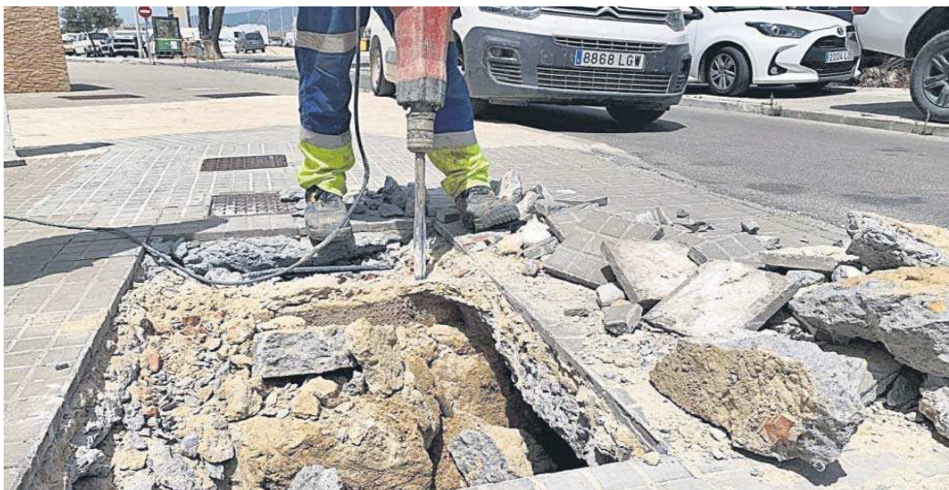
La reparación de una de las averías.
