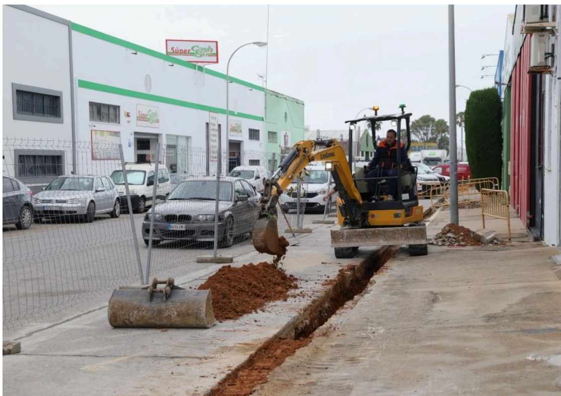
Obras con cortes de agua en Rota.
