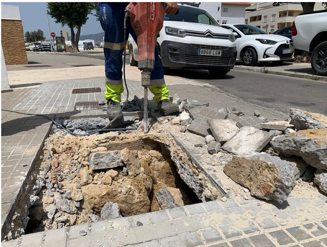
Reparación del sistema de abastecimiento de agua en Tarifa.
