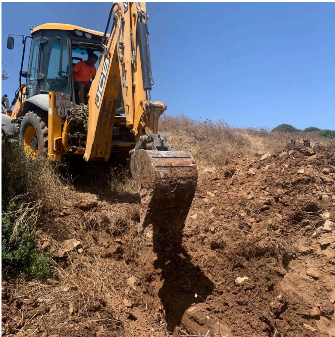
Imagen de los trabajos para reparar la avería del fin de semana.
